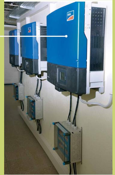
Die Solarzellen auf dem Dach wandeln die Sonneneinstrahlung direkt in elektrische Energie. Im Keller sind Akkus zur Speicherung installiert sowie Wechselrichter zur Einspeisung der Energie ins öffentliche Stromnetz.
